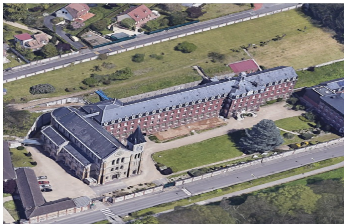
La localisation du projet d'Habitat Participatif se situe en haut à droite sur la partie herbée.
